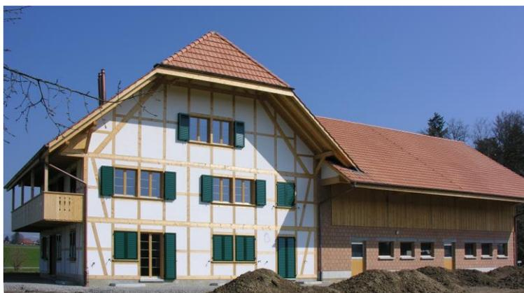
1 Giebel mit Fachwerkkonstruktion
