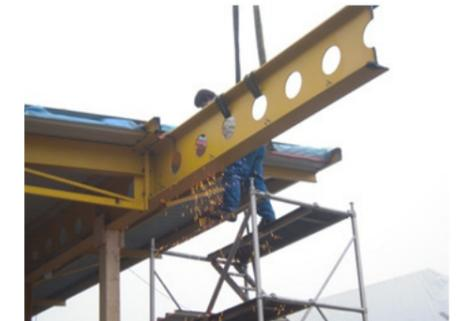
Teilabbruch der Stahlkonstruktion
