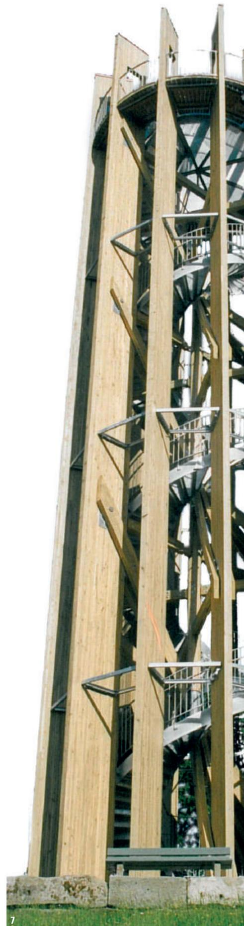
Trapezrahmen aus Stahl. Die horizontale Lastabtragung erfolgt über räumlich angeordnete Diagonalen, die im Verbund mit den vertikalen Hauptlamellen als stehende Fachwerke funktionieren. Die Diagonalen laufen im Zentrum des Turms in drei Hauptknoten zusammen.
