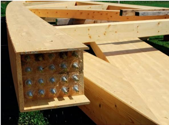
Montage der Primärstruktur: Vom zuletzt montierten Binder abgesehen, wurden zunächst Trägerhälften eingeschwenkt und danach an Ober- und Untergurten die Montagestösse im Ferwoodsystem ausgeführt.
