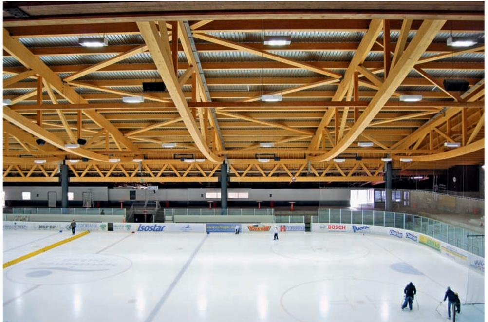
Aus dem Schadensfall gelernt: Die permanente elektronische Überwachung des Hallenklimas zielt – in Kombination mit einer Luftentfeuchtungsanlage – darauf ab, die klimatischen Einflüsse auf die Holzfeuchtigkeit zu überwachen.
