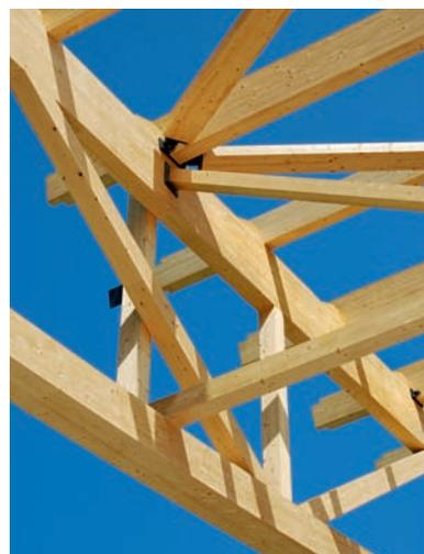
Als Auflager für die Fischbauch-fachwerke in Brett-schichtverleimter Ausführung dienen die ehemaligen, jedoch merklich gekürzten Pylonen, Stahlstützen und Längsfachwerke. Unterhalb der Sparrenpfetten angeordnet, aber in die Dachebene integriert, sorgen verleimte Windverbände für die seitliche Stabilität der Primärträger.
