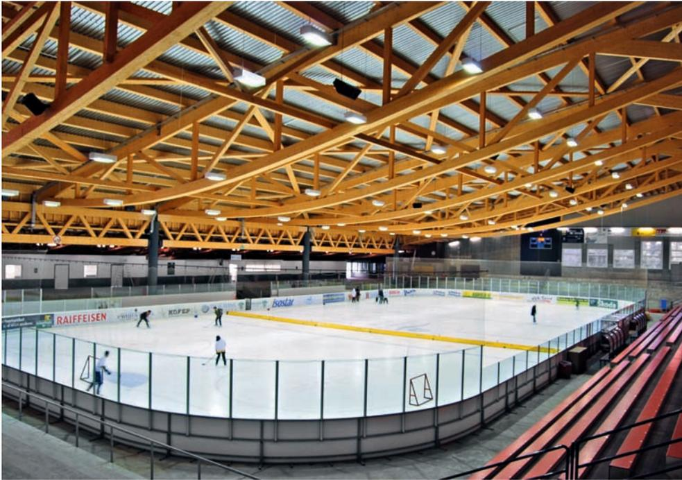
Dem alten, maroden Hallendach weint niemand mehr eine Träne nach, denn in den Sommermonaten 2009 ist die Eissportanlage in Zuchwil mit einem neuen Tragwerk in Holz zu einer Halle ausgebaut worden.
