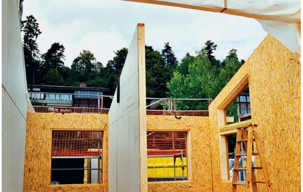
**Die Aussenwände waren weitgehend vorgefertigt und grösstenteils mit Installationsleitungen versehen (oben). – Der Finish bei den nur einseitig beplankten Innenwänden (unten) erfolgte auf der Baustelle. – Für die Sparrenlage wurde bewusst BSH-Konstruktionsholz verwendet (ganz unten).**
