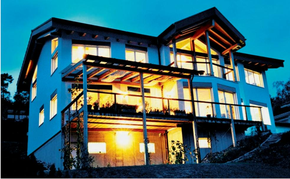
Ein Baukörper mit kompakter Geometrie, eine gute Wärmedämmung, eine dichte Gebäudehülle sowie ein gesteuertes Belüftungssystem machen das Haus Maeder in Evilard zum Minergiehaus.
