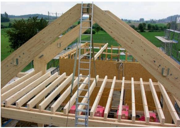
Die beiden BSH-Dreigelenkrahmen (links) nehmen in der Mitte auch Lasten über Zugstangen (rechts) aus dem Heuboden auf. – Vielhändig wie einst: Setzen der Firstpfette (unten, links).
