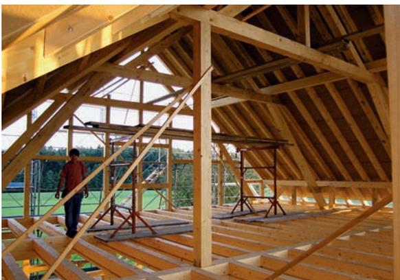
Das Artishus im Rohbau (oben, rechts). Das Dachgeschoss (links) ist jederzeit ausbaubar. Partiiell und mit Pressverleimung als Aussteifung des Riegelwerkes verwendet: Furnierschichtholzplatten (rechts).
