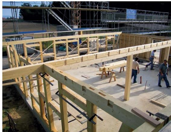
In die Rekonstruktion des Wohnteils im traditionellen System des Riegelbaus flossen neuzeitliche Holzbautechniken in Form von Verbindungsmitteln und vorgefertigten Elementen ein.
